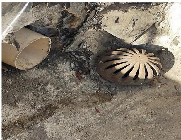
Foto 2- Ralo tipo abacaxi com infiltração;
