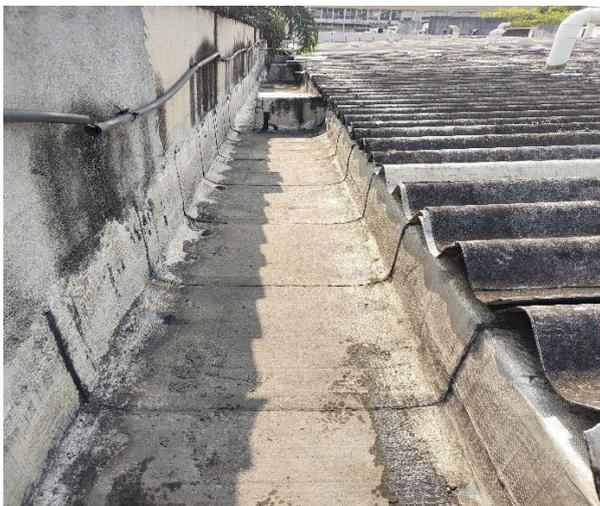
Foto 7 – Telhas quebradas e menores, provocando retorno de de água pluvial;
