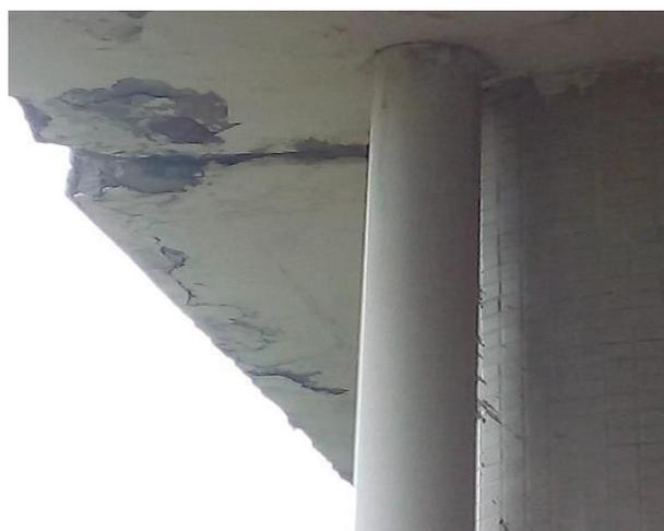
Foto 6 - Estrutura danificada pela infiltração;
