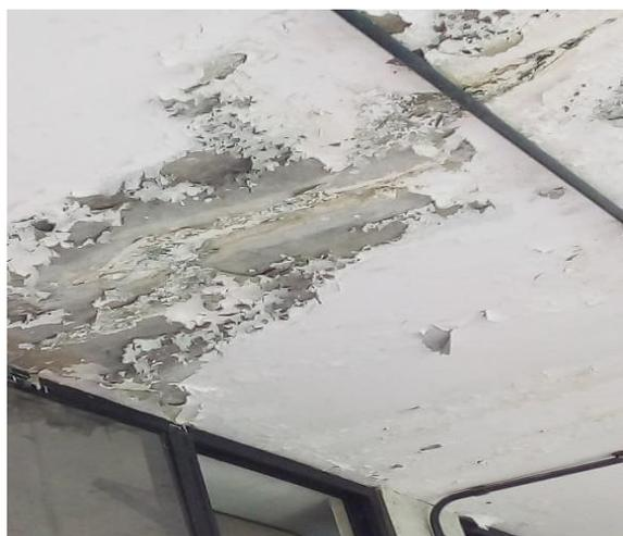
Foto 5 - Infiltração no teto provocado por trinca;
