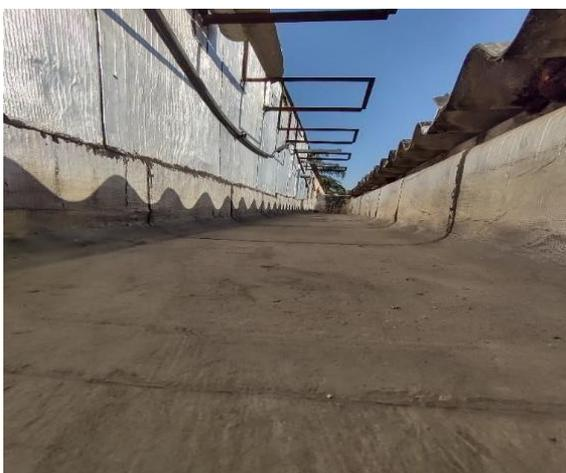
Foto 1- Calha de 52mx,90, com manta danificada;
