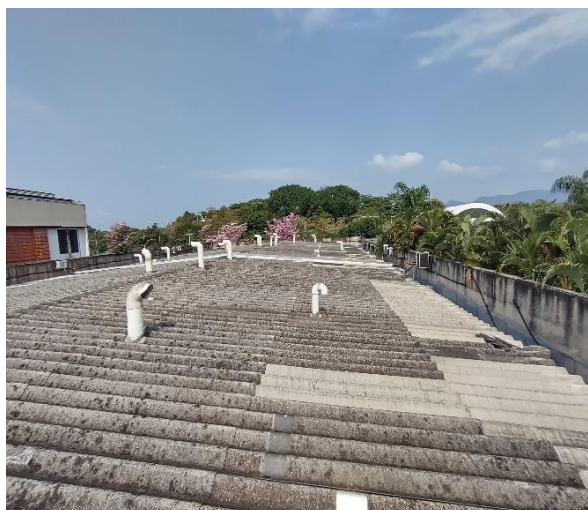
Foto 8 – Saídas dos sistemas de exaustão para serem impermeabilizadas com Bidim,
